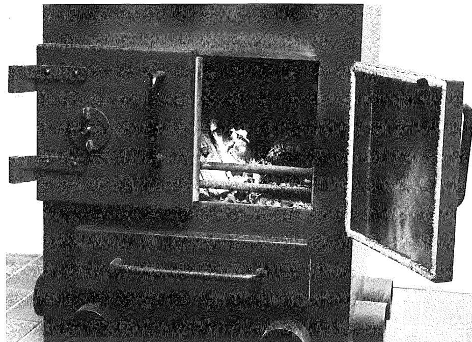
Asbestsnor som pakning på pejselåge.
