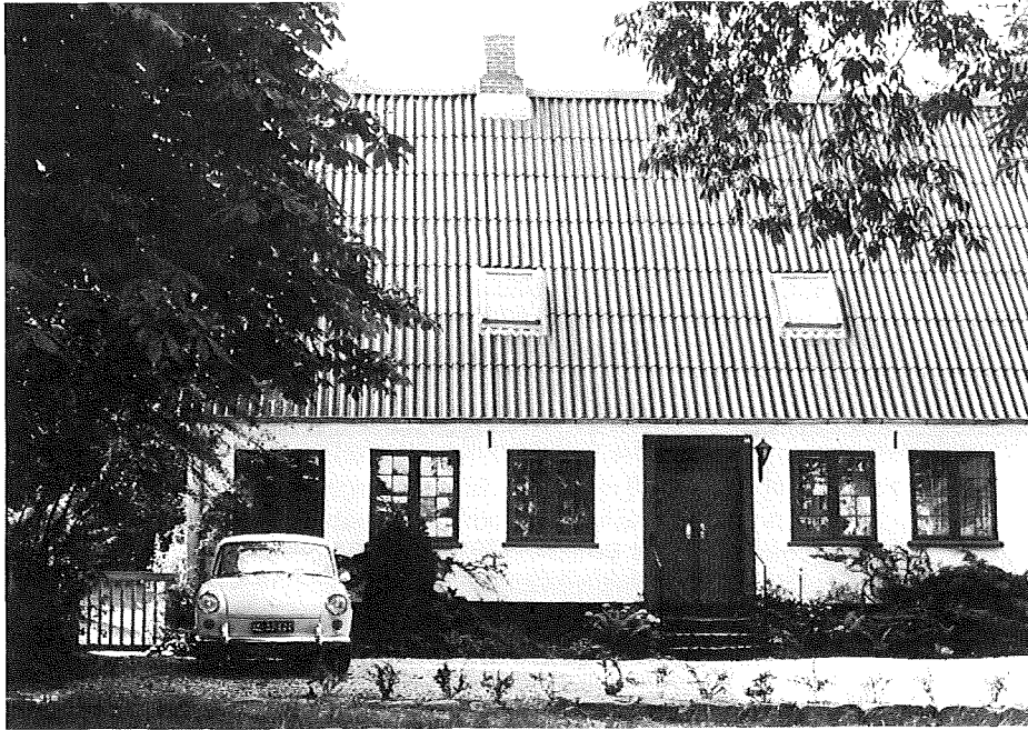
Eternit B6 bølgeplade som tagbeklædning.
