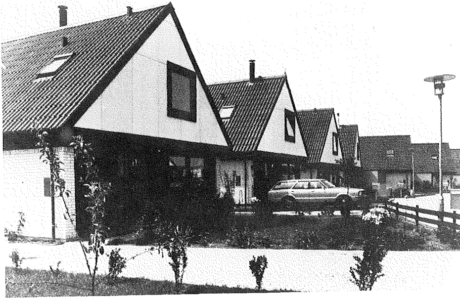
Eternit B7 bølgeplade som tagbeklædning og Eternit-facadeplade som gavlbeclædning.
