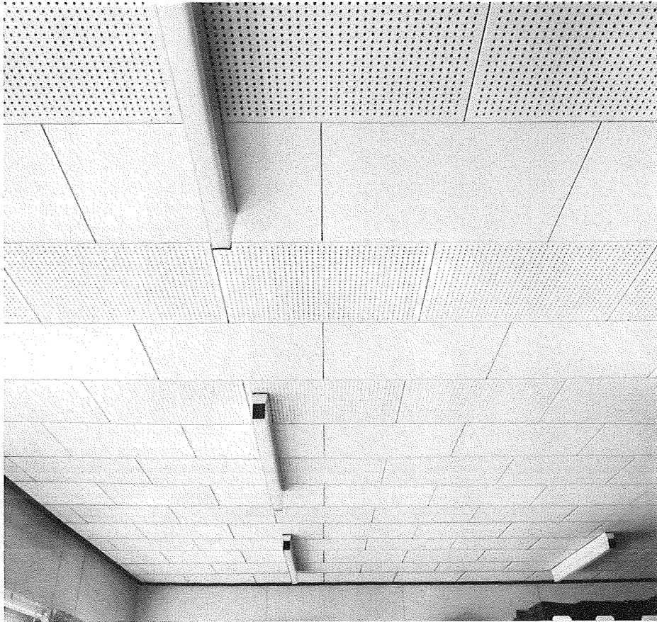
Plan, perforeret og uperforeret gipsplade som loftsbeklædning.
